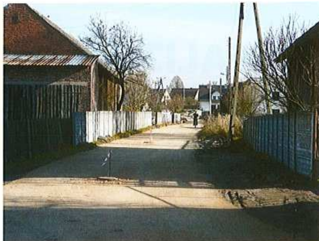
ul. Podole w trakcie realizacji
