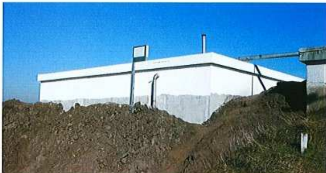
Oczyszczalnia w Ciasnej
