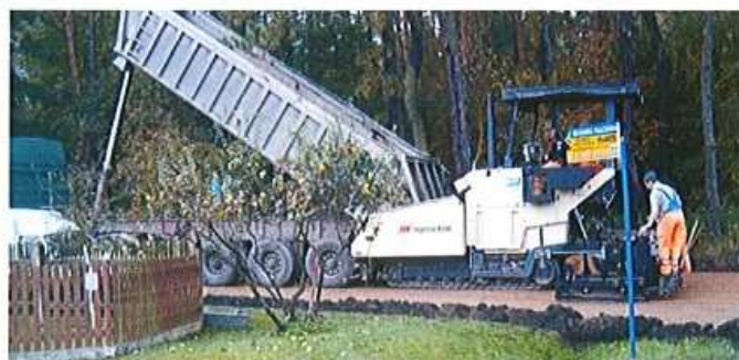
ul. Hubala w trakcie budowy
